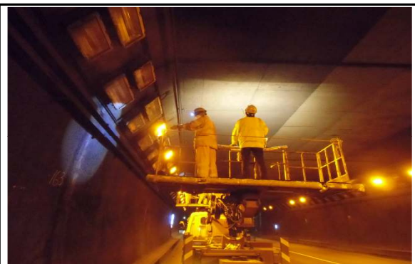
고소점검차를 이용한 외관조사(예)
