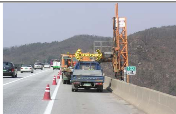
교량굴절차를 이용한 외관조사(예)
